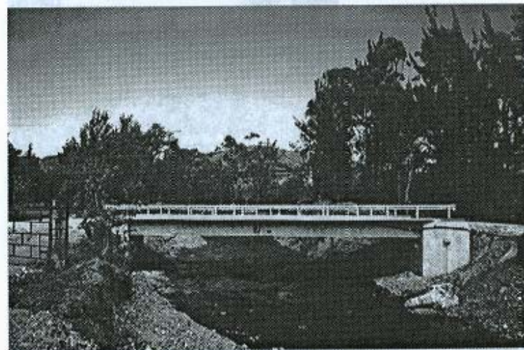
Reposición con diseño de ingeniería apropiado y medidas preventivas de un puente anteriormente destruido por una crecida del Río Purires.
