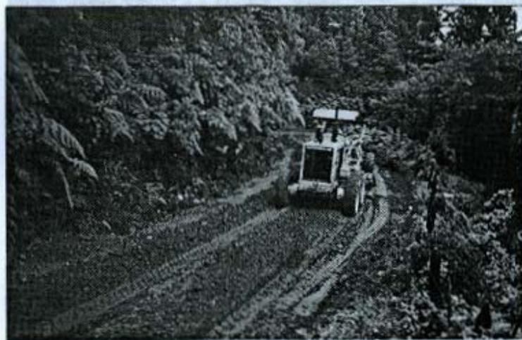
Reparación de camino vecinal destruido por un deslizamiento.
