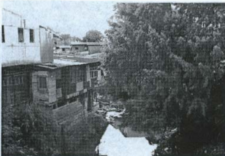
Viviendas en sector del Cantón de Tibás susceptibles a inundaciones y deslaves.
